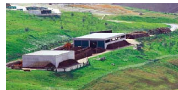
L'impianto di compostaggio
